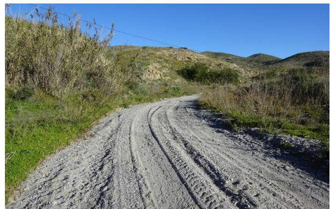
Figura 7. Las rodaduras de los vehículos como motos, o quads alteran profundamente la morfología del cauce y muchas funciones ecológicas. Autora: M.R. Vidal-Abarca.
