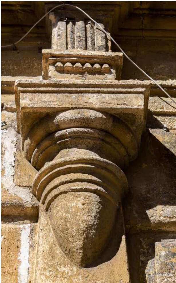
Figura 24. Calcarenitas. Detalle del capitel que remata la pilastra de la fachada del Casino.
