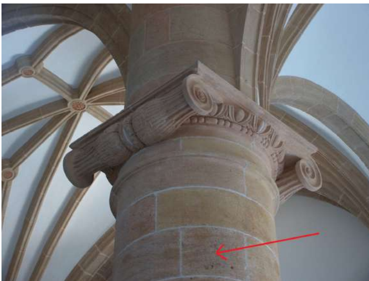
Figura 36. Bóvedas y capitel de columna de la iglesia de Santa María Magdalena. La flecha roja señala las estratificaciones cruzadas en las calcarenitas del fuste.
