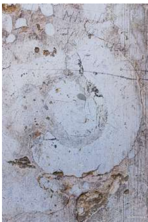
Figura 16. Detalle de las calizas nodulosas rojas decoloradas en la fachada del palacio de los Fajardo.
