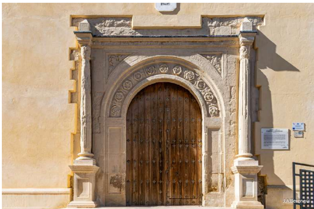
Figura 25. Fachada de la iglesia de la Inmaculada Concepción.
