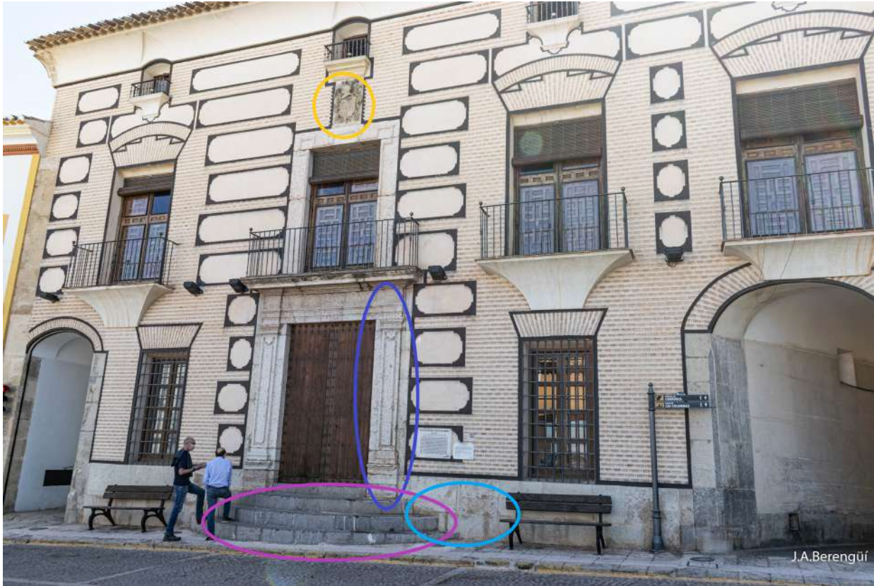
Figura 18. Fachada del palacio de los Fajardo. Violeta: calizas triásicas. Azul oscuro: calizas rojas de la formación Ammonítico Rosso. Azul pálido: sillares de calizas rojas del ammonítico Rosso y calizas blancas del Kimmeridgense. Amarillo: areniscas.
