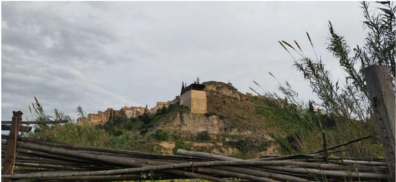
Figura 33. Torre del Pozo.
