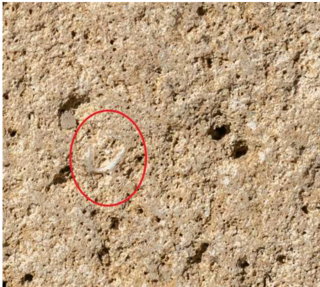
Figura 12. Detalle de calcarenitas. Fachada del Casino. Enmarcada en rojo la concha de un bivalvo.
