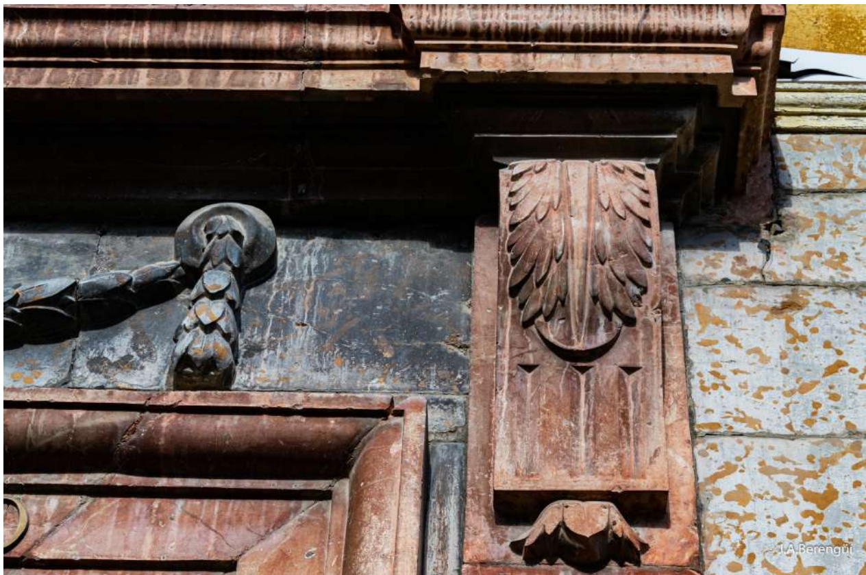
Figura 28. Fachada de la Casa de Jaspe. Detalle. Obsérvense las calizas rojas del Ammonítico Rosso y las calizas triásicas. En estas se distingue la decoloración.
