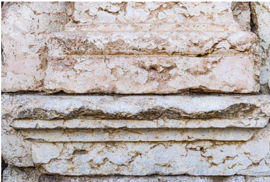
Figura 16. Detalle de las calizas nodulosas rojas decoloradas en la fachada del palacio de los Fajardo.
