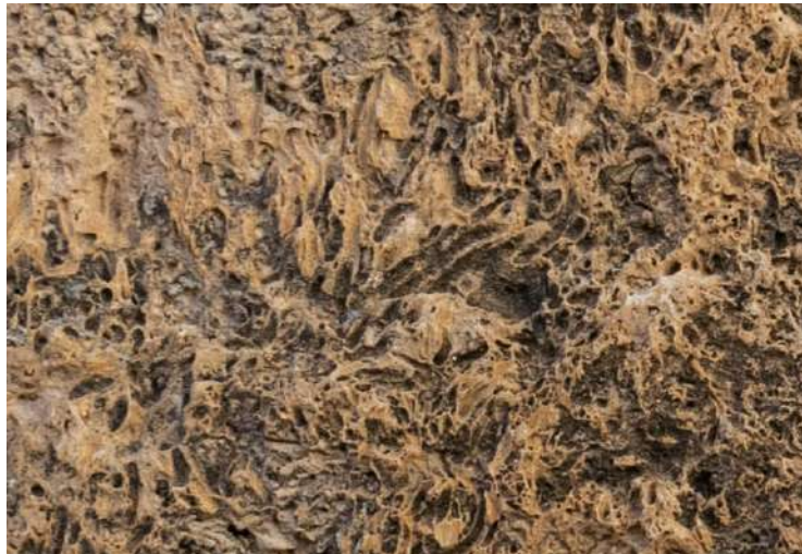
Figura 13. Detalle de un bloque de tobas de la antemuralla. Obsérvense los moldes de los tallos.
