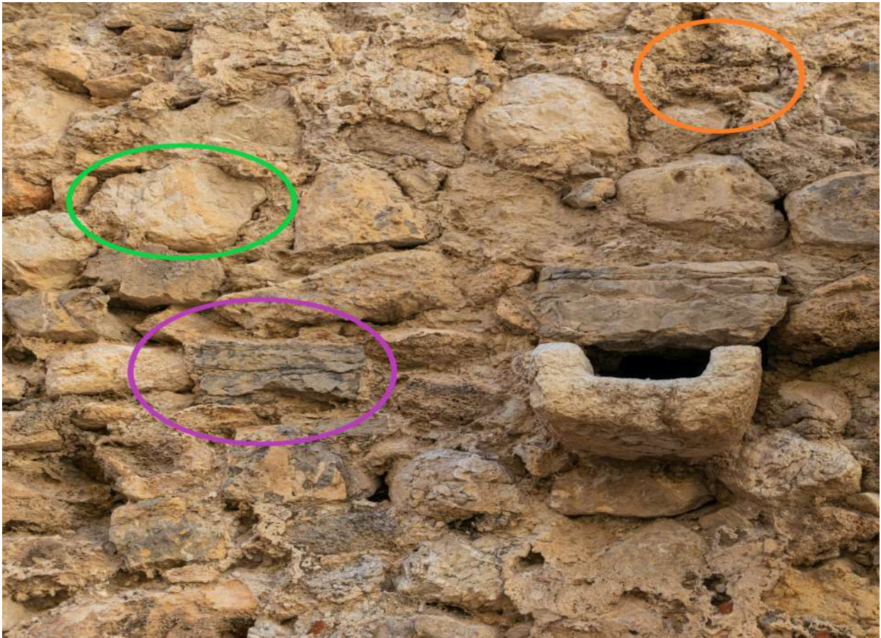
Figura 30. Detalle de la antemuralla con ejemplos de las diferentes litologías usadas en su construcción. Morado: calizas triásicas. Verde: calizas margosas albienses. Naranja: tobas cuaternarias. Se conserva el aliviadero de evacuación de aguas pluviales.
