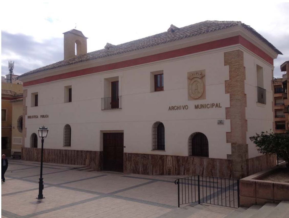
Fachada de la Biblioteca y el Archivo Municipal
