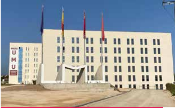
Edificio de aulas y laboratorios de prácticas del Campus de Ciencias de la Salud
