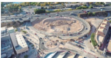
Rotonda de Acceso Este al Campus de Espinardo (fase de ejecución)
