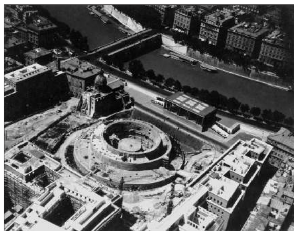
Figura 37. Operaciones de regularización de los muros del Augusteo.
