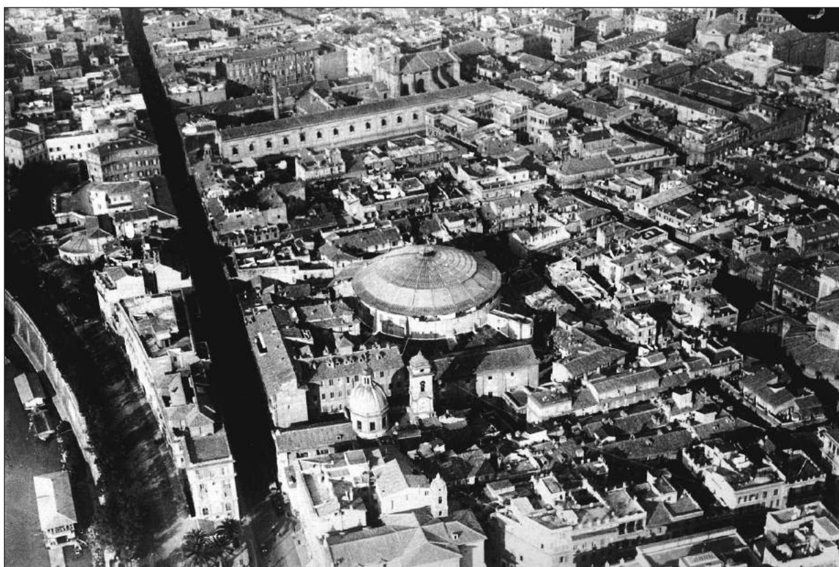
Figura 28. Vista aérea de la zona del Tridente en la que emerge, por su volumen, la cúpula del Auditorium.
