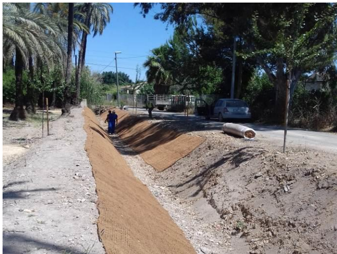
Figura 6. Revestimiento con manta orgánica del Azarbe del Cantino. Juan Nicolás Zomeño.
