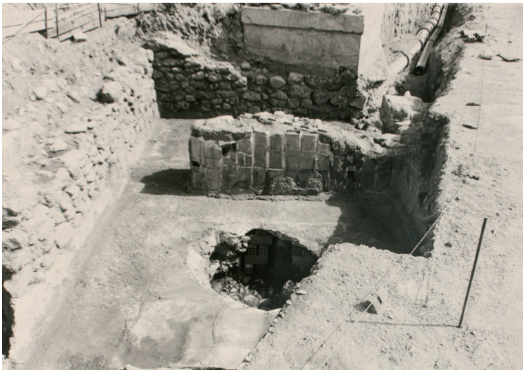
Figura 8: Vista general de las termas en el proceso de excavación (Fuente: Archivo Histórico Regional de Murcia)
